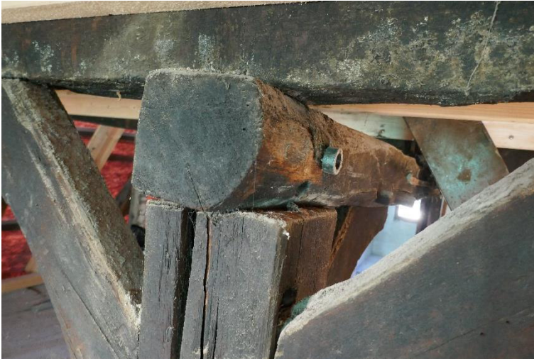
Abbildung 4: Zentrale Dachwerkkonstruktion 1493 (Foto Mathias Polster)
