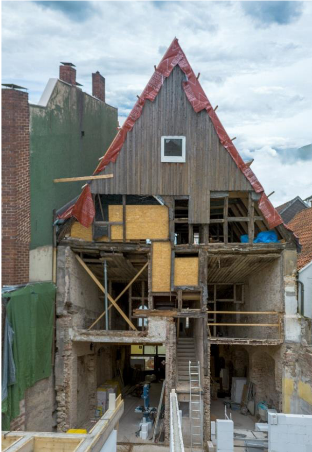
Abbildung 3: Fachwerkkonstruktion um 1500 (Foto Lars Oliver Gehring)
