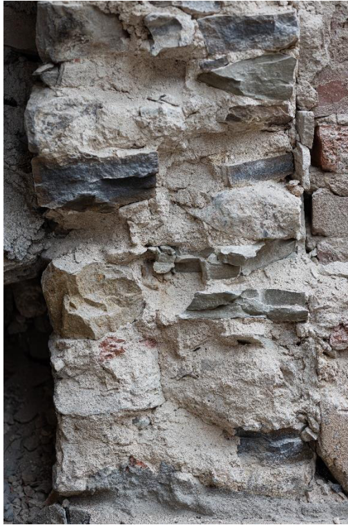
Abbildung 2: Aufgehendes Mauerwerk aus Rhätquarzit (Foto Lars Oliver Gehring)
