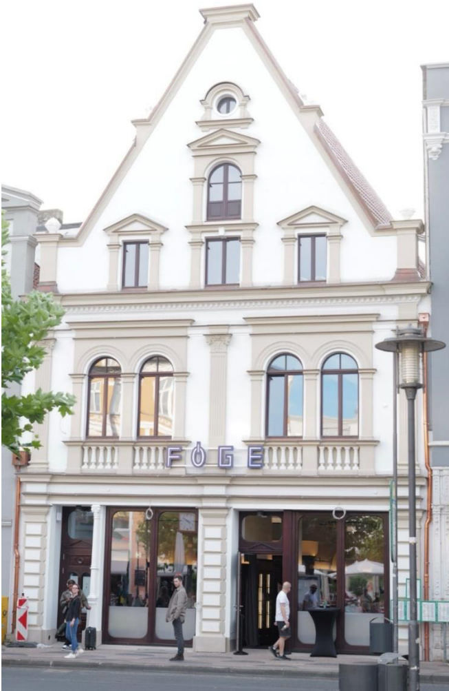
Abbildung 11: Die denkmalgeschützte Fassade in neuem Glanz
