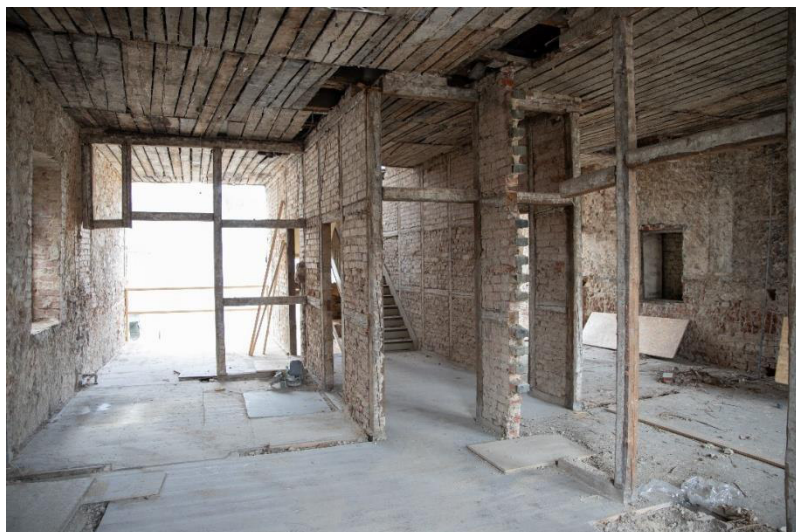
Abbildungen 9+10: Während der Sanierung
