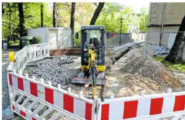
In der Baugrube hinter der Münsterkirche fanden die Bauarbeiter den gemauerten Tunnel.
