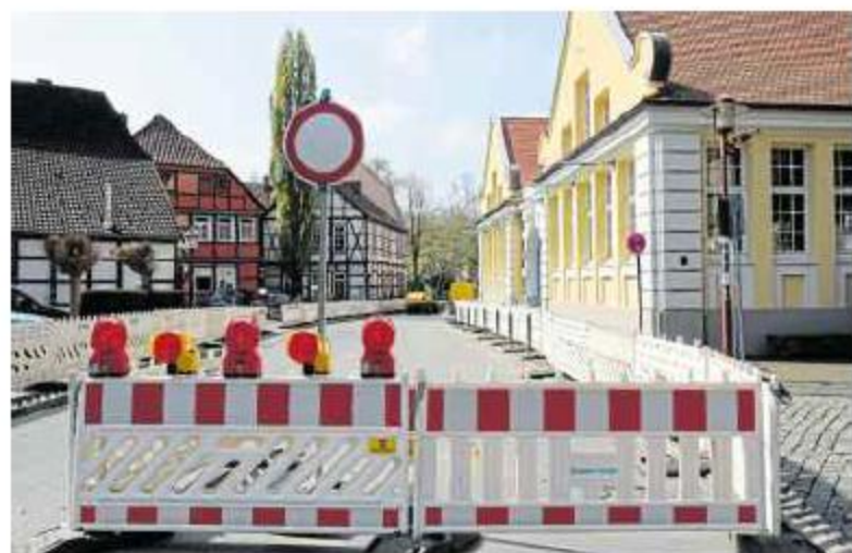
Die Elisabethstraße hinter der Markthalle ist derzeit gesperrt für die Verlegung von Versorgungsleitungen.
