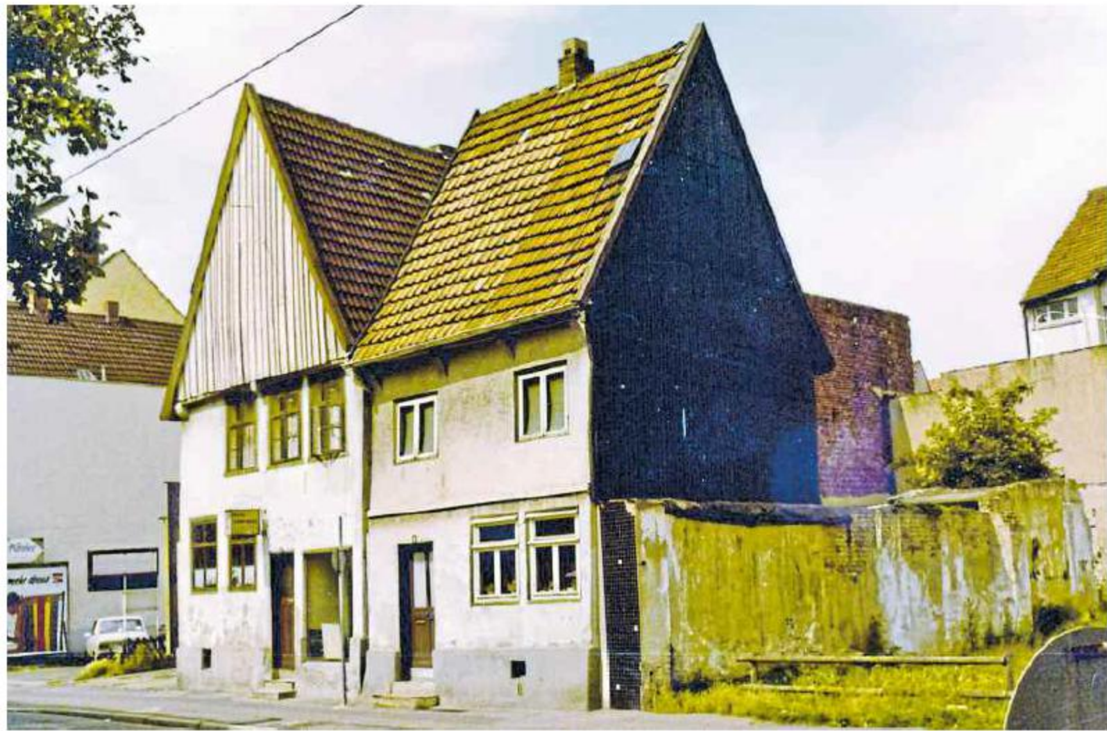
Die Bürgerinitiative befreite die dem Abriss geweihten Fachwerkhäuser Komturstraße 9 und 11 vom Putz.
