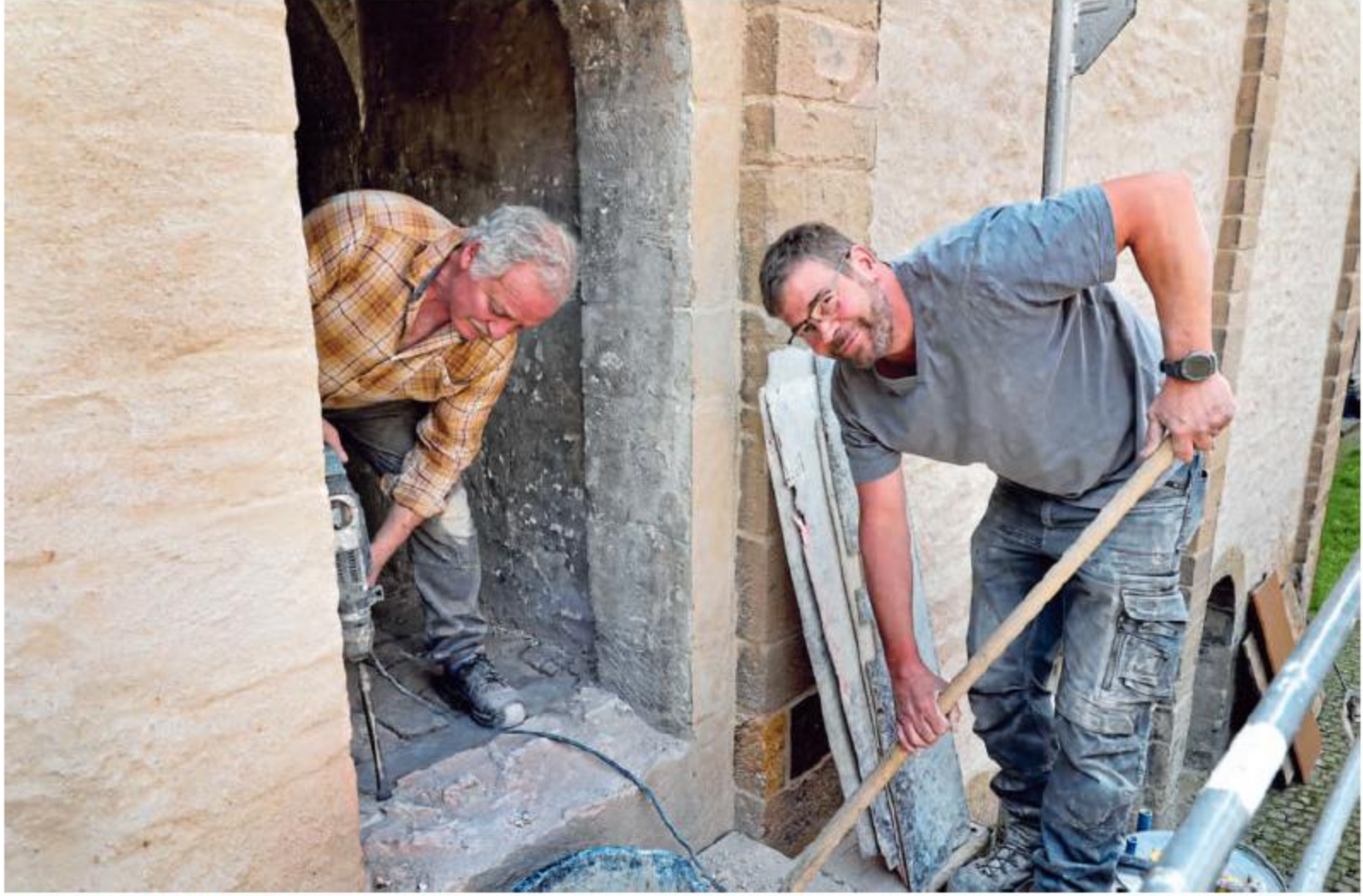
Hubert Gruber und Matthias Plöger haben die Tür in der Nordfassade der Münsterkirche geöffnet.
