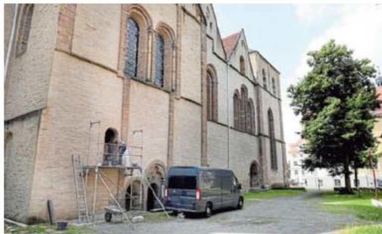
Die Tür in der nördlichen Kirchenfassade hat derzeit keine erkennbare Funktion.
