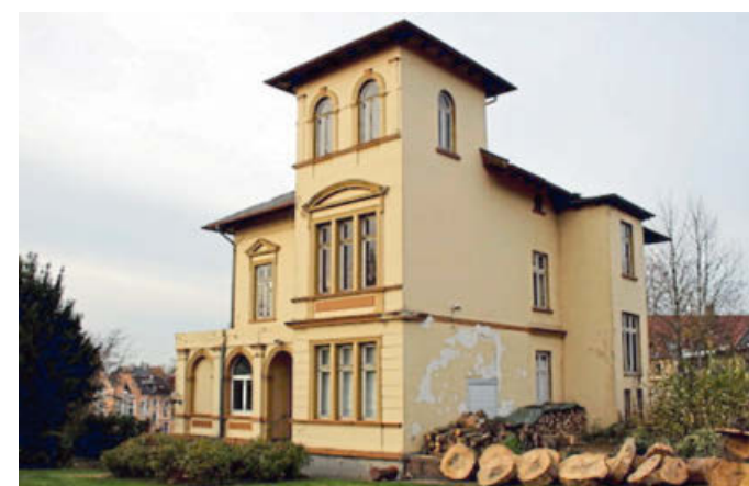
Die Villa Jahnstraße 6 vor der Sanierung. Foto: privat
