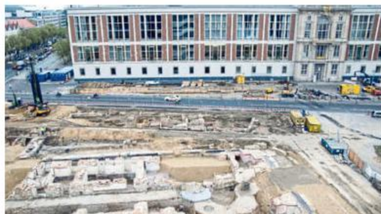
Freigelegt: Fundamente des Schlosses und des Cöllner Dominikanerklosters vor dem ehemaligen Staatsratsgebäude der DDR.
