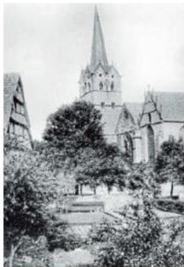
Blick von Südosten auf die Münsterterkirche, kurz vor 1890. Links der Rückgiebel des 1894 abgebrochenen Hauses Münsterkirchplatz 1. REPRO: ARCHIV
