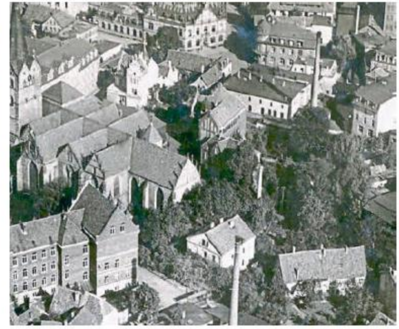
Ein Luftbild aus der Zeit um 1920: Einer der Schornsteine befindet sich in der Nähe der Münsterkirche (Pfarrgarten). Dort sollen die Kessel für die Heizung erhitzt worden sein. .... Foto: Archiv Polster
