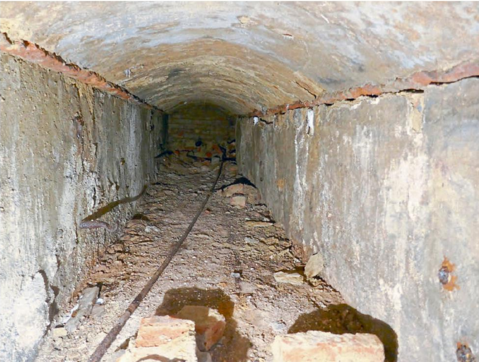
Blick ins Innere des Heizungskanals, durch den vermutlich Münster und Kantorenhaus mit Wärme versorgt wurden.
