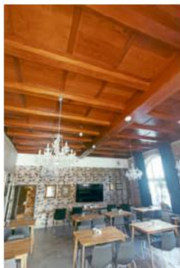
Eine der Zimmerdecken, die unter Denkmalschutz stehen.
