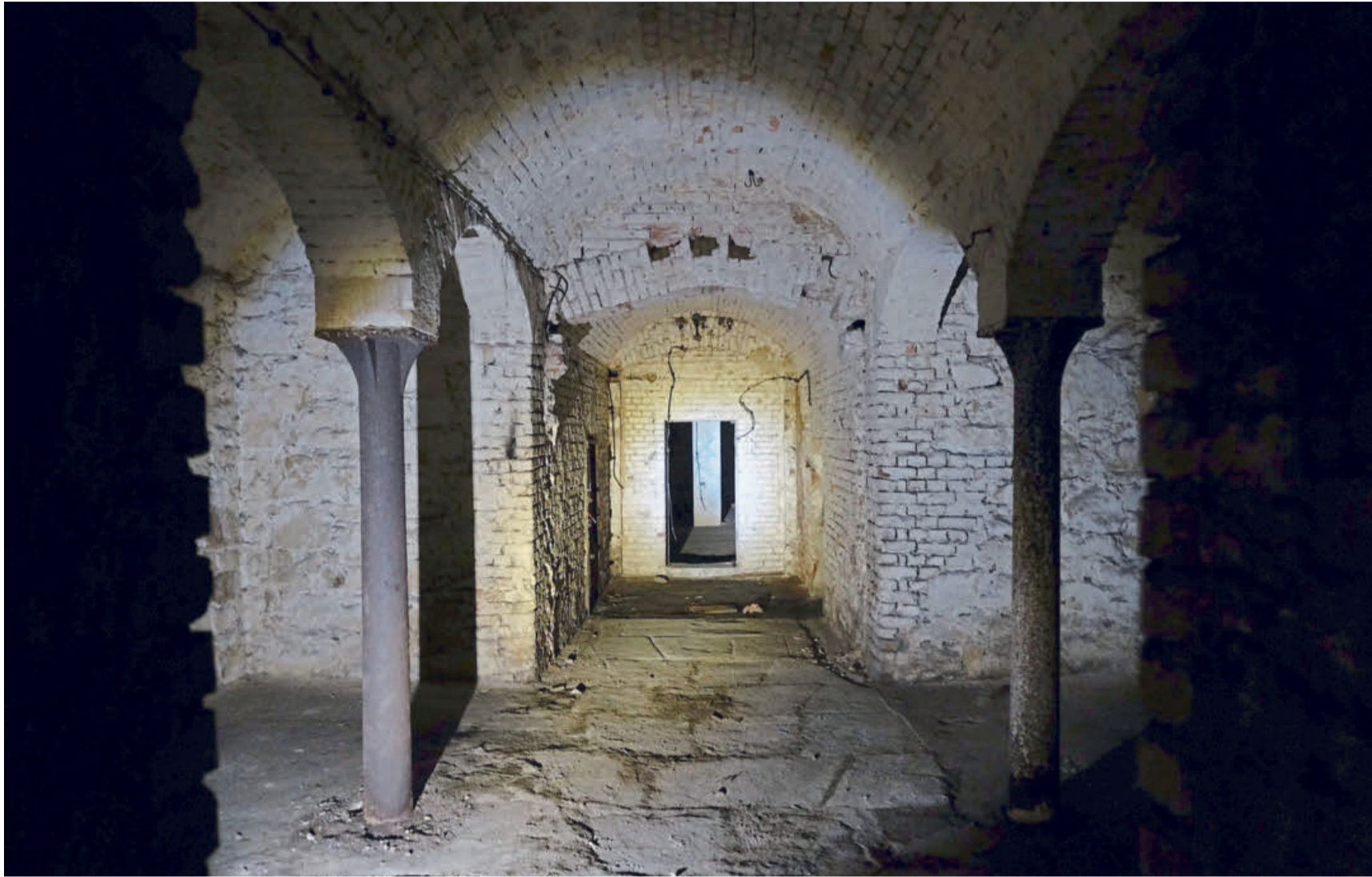
Das Gewölbe an der Jahnstraße: Es diente als Brauereikeller und Luftschutzbunker. Später wurden hier auch Champignons gezeitet.
