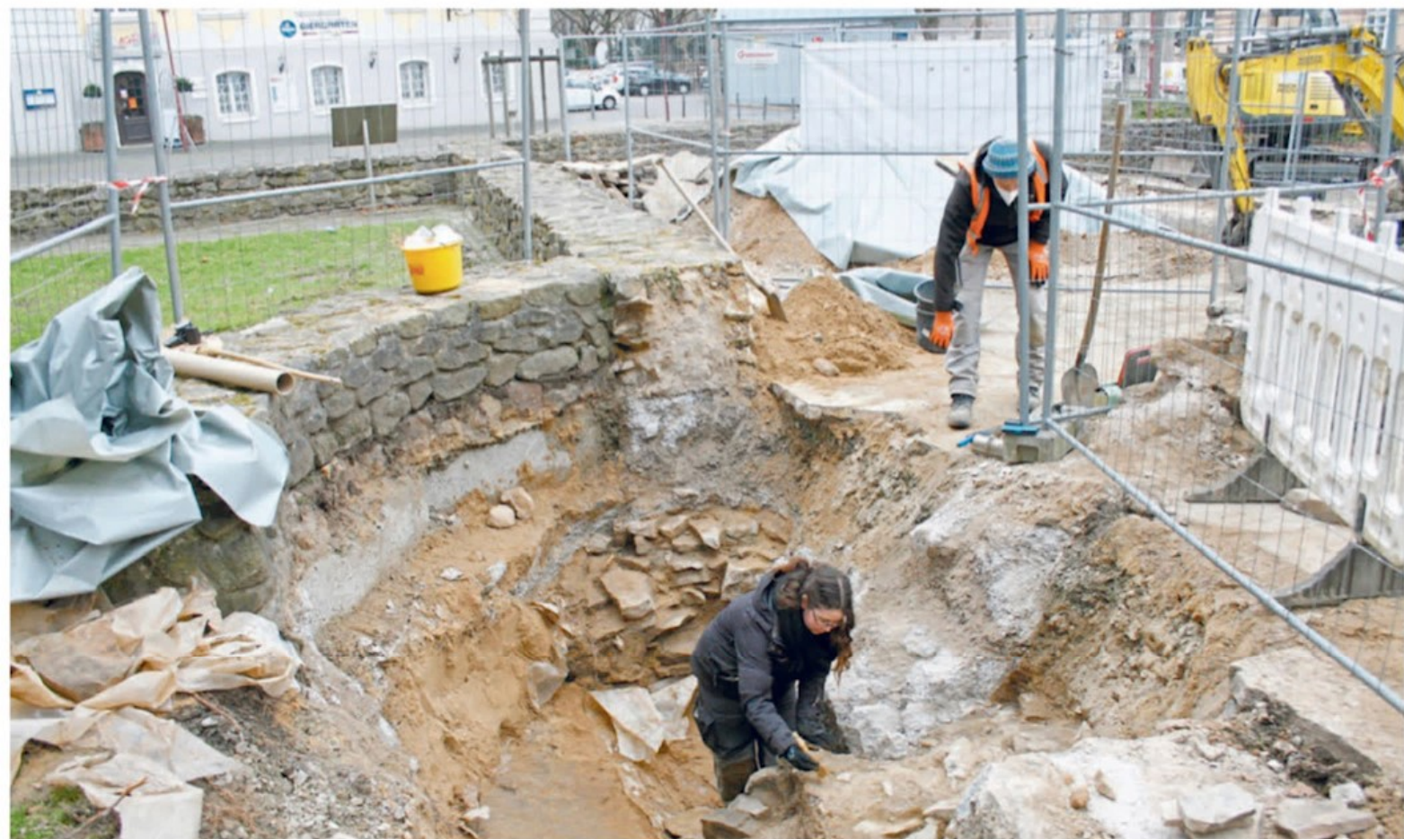
Die Grabungsarbeiten ermöglichen einen Blick auf die Anfänge des Frauenstifts am Münster. Über den alten Mauern im Erdreich soll das Archäologische Fenster entstehen.
