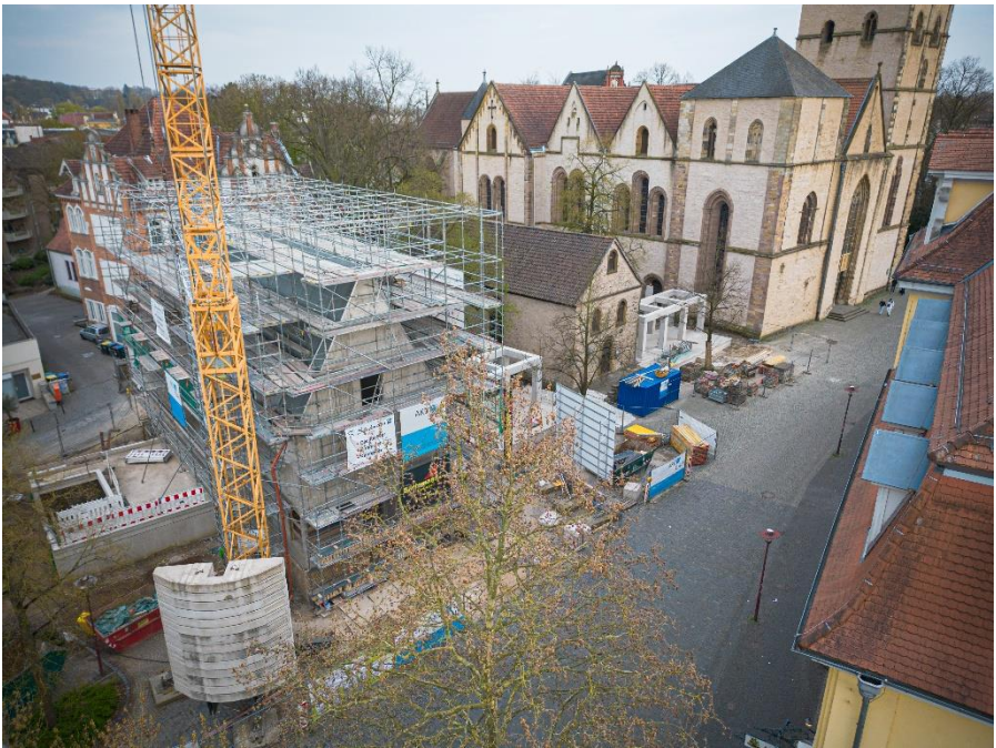
Abbildung 1: Baustelle im April 2025 - es geht mit großen Schritten voran
