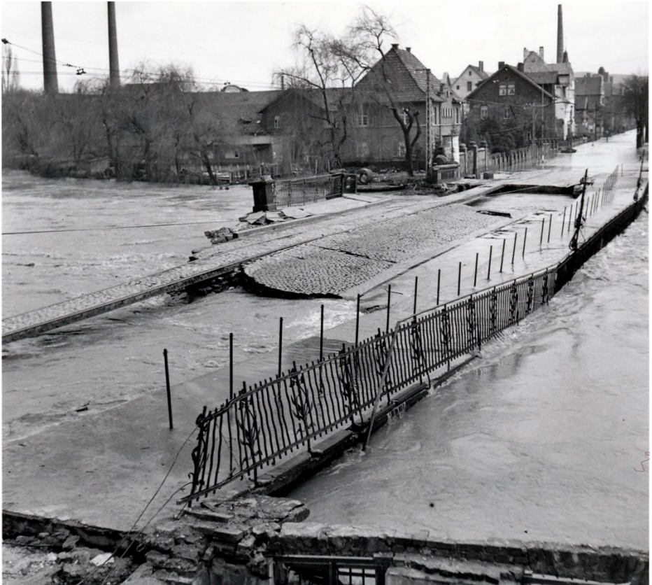
Abbildung 10: Die Hansabrücke wurde so stark beschädigt, dass sie neu errichtet werden musste. (Sammlung Rainer Pape)
