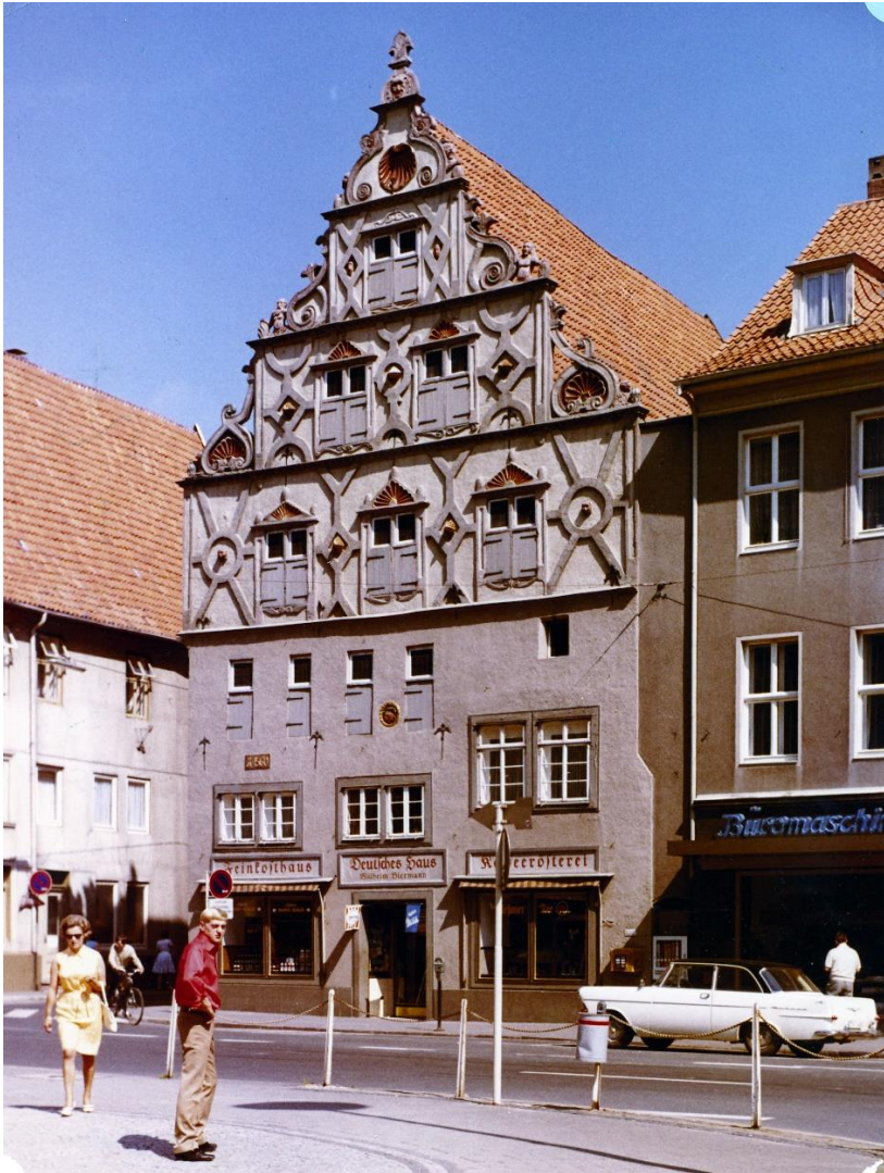
Abbildung 1: So sah das Wulferthaus vor dem Rückbau aus. Der Erker war nicht mehr da und die großen Fenster waren zugemauert. (Foto Jürgen Witte)
