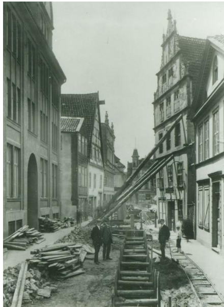
Anlage der Kanalisation in der Lübberstraße (1912) (Foto: Archiv Geschichtsverein)
