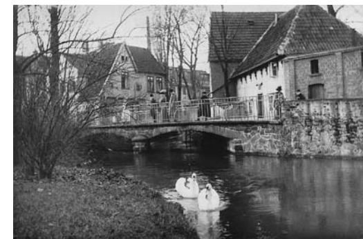
Die verschwundene Osterbrücke über die Bowerre an der Johannisstraße.
