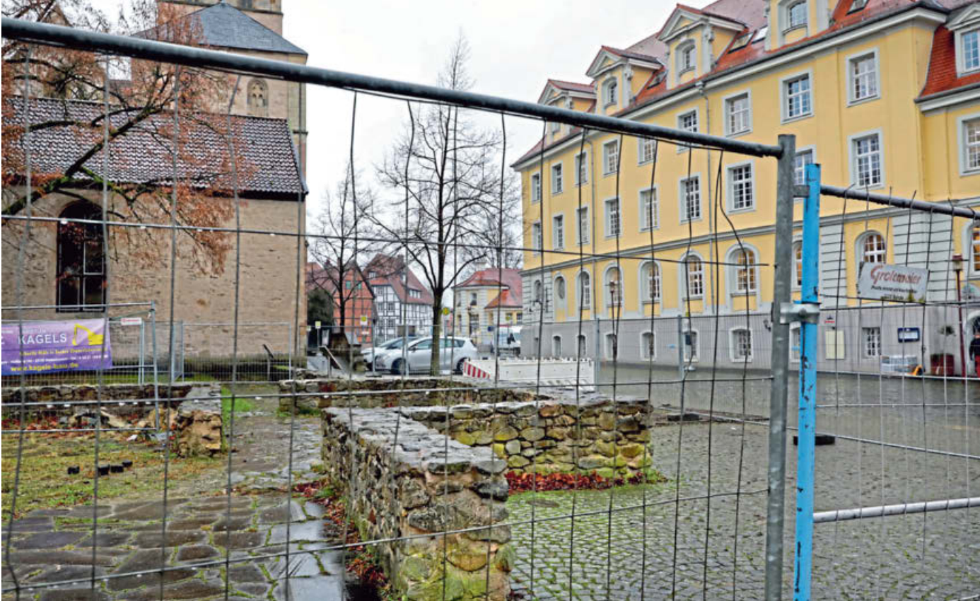
Ab nächster Woche sollen die nachempfundenen Grundmauern des Damenstiftes abgerissen werden. Die Fläche zwischen Münster und Rathaus wird ab da auch für einige Zeit den Busverkehr vom Alten Markt aufnehmen.
