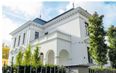
Jutta und Hermann Huss haben die Villa am Wilhelmsplatz 2022 erworben und denkmalgerecht und zugleich zeitgemäß restauriert.
