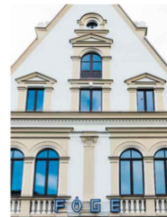
Das Föge-Fassade orientiert sich an der alten Gliederung.
