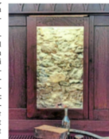
Das historische Fenster von Föge: Die sichtbar gemachten Maueres- te stammen vermutlich aus dem 14. Jahrhundert.
