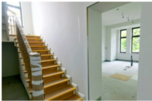
Die Treppe orientiert sich am Original. Weil die Aufarbeitung der alten Substanz nicht möglich war, entschied man sich in Absprache mit dem Denkmalmaltr für einen Nachbau.
