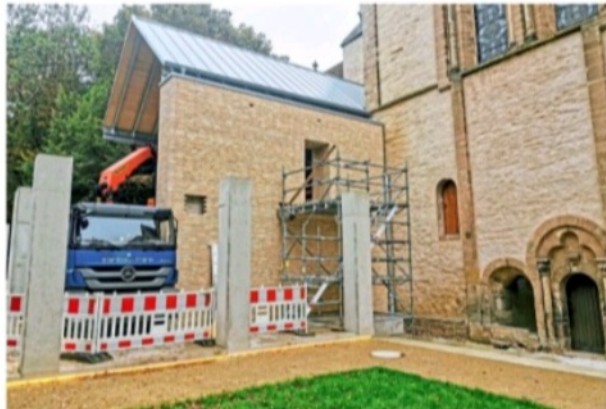
Blick auf das kleine Gebäude, das ans Münster grenzt: Sind die Arbeiten abgeschlossen, können die Ausstellungsmacher mit der Installation der Medien und Vitrinen beginnen. Foto: Hartmut Horstmann
