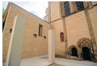
Aus dem Gebäude 2 (l) soll es zukünftig einen Zugang zur Chorempore der Münsterkirche geben (Tür oben in der Wand).
