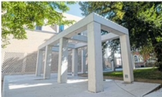
Kolonnadengänge und Betonstelen machen den Verlauf des früheren Kreuzgangs erfahrbar. Ganz nebenbei ist ein neuer Ort der Ruhe mitten im Stadtzentrum entstanden.
