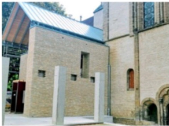
In der nächsten Woche soll mit den Stahlarbeiten begonnen werden. Vom neuen Gebäude aus wird es einen Balkon/Steg zum Münster geben. Die Öffnungen sind bereits zu sehen.
